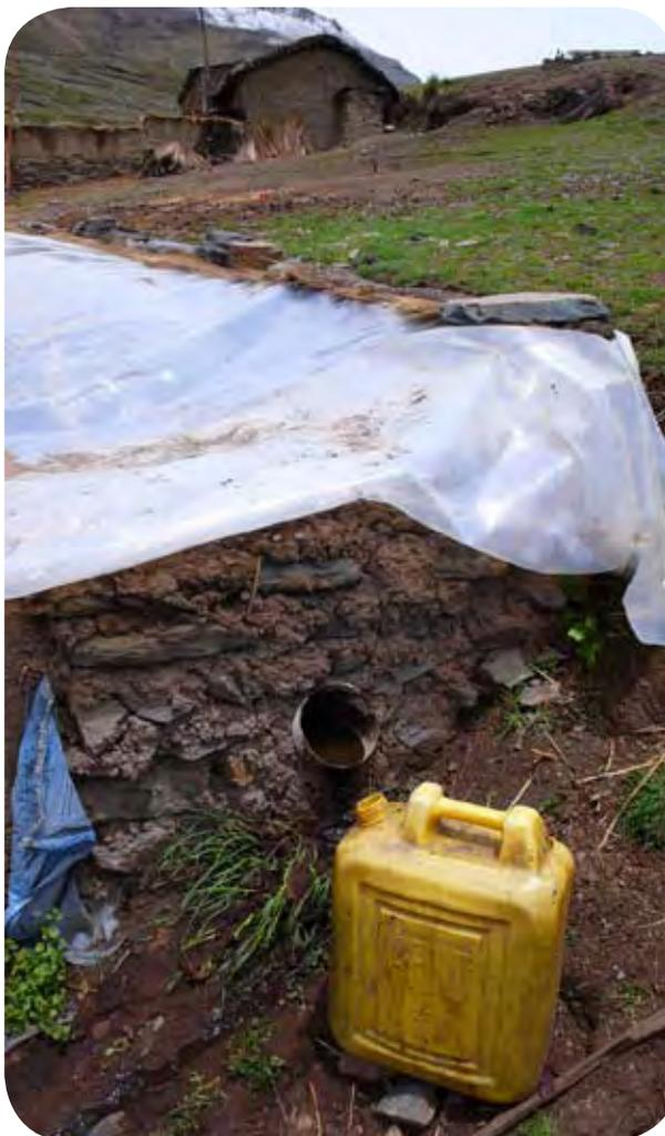
**Figura 9:** Salida del biodigestor por donde se derrama el biol.
