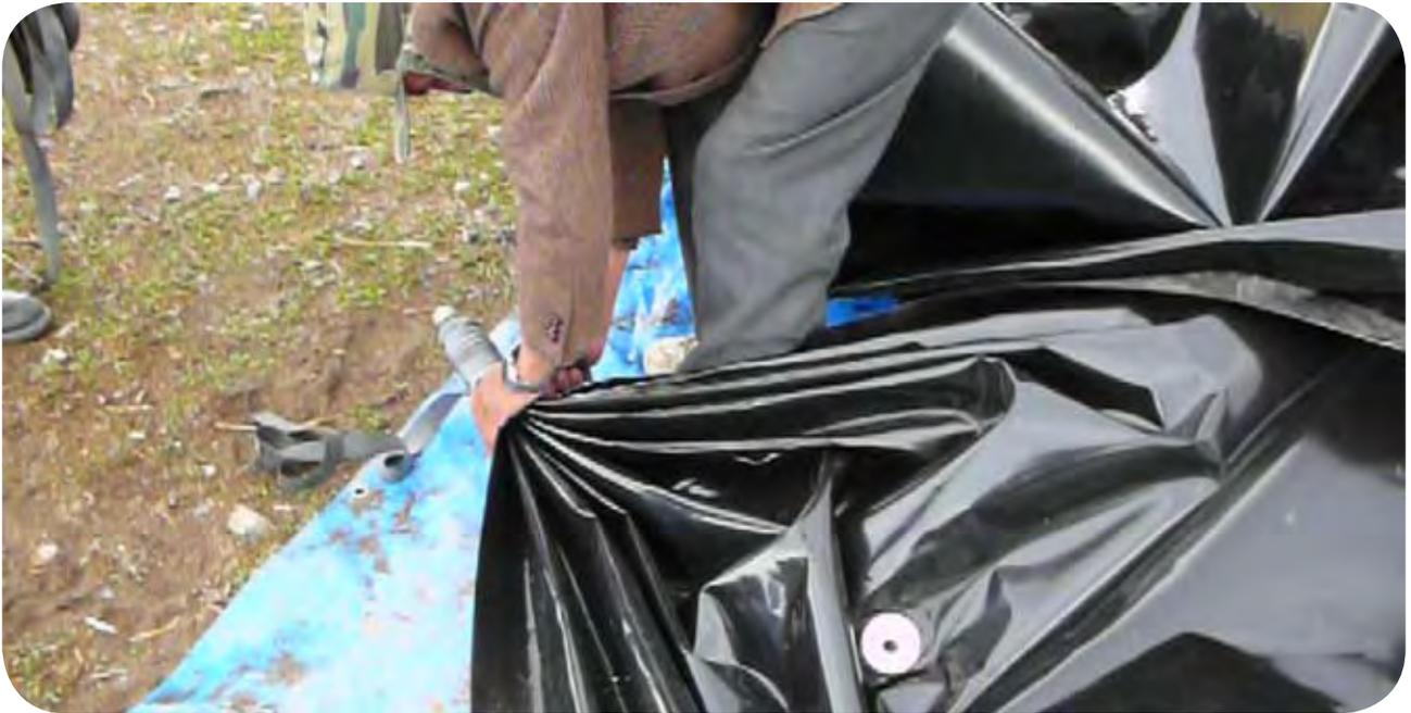
**Figura 30:** Se amarran los lados sellados, plegándolos en forma de acordeón, contra un objeto hueco, para poder pasar una pita por el hueco y así colgar el biodigestor del techo.
