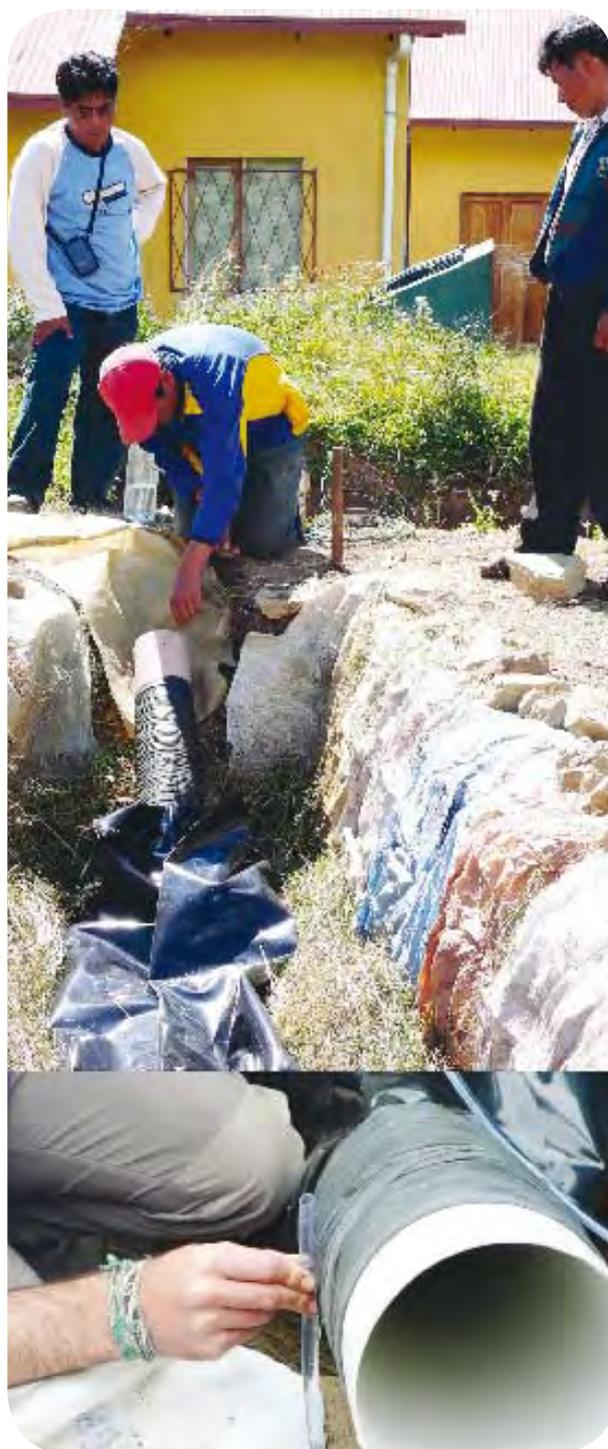
**Figura 22:** Para medir los niveles de salida es muy fácil se debe emplear una manguera transparente llena de agua que dará el nivel.
