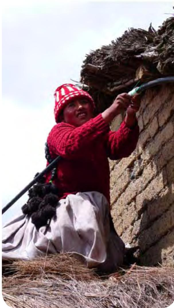
**Figura 26:** La conducción de biogás se hace con tubería de riego (politubo, tubería PED, tubería de pvc) de ½”, se usan los accesorios comunes, siempre con rosca.
