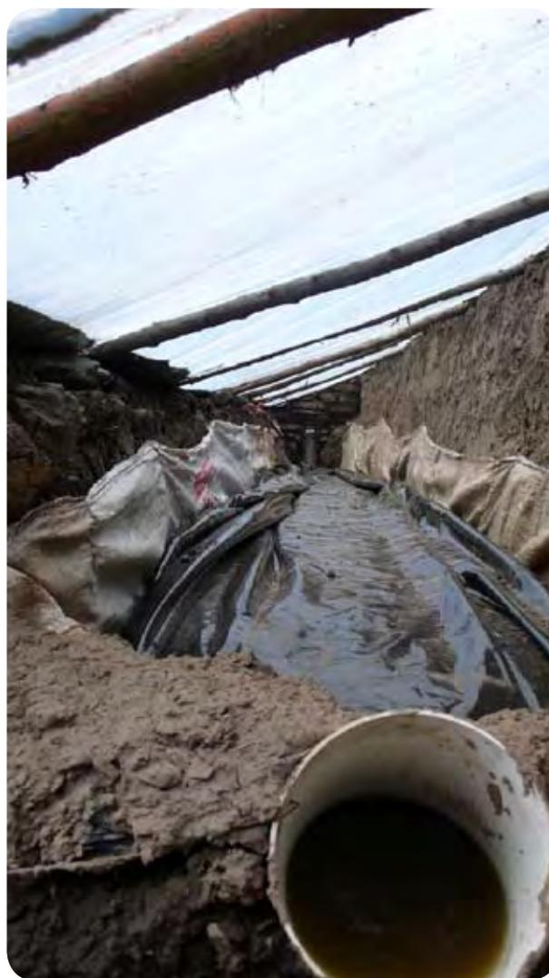
**Figura 4:** Biodigestor recién instalado en altiplano y en proceso de empezar a producir biogás (Pakuani, La Paz, 4200 msnm)
