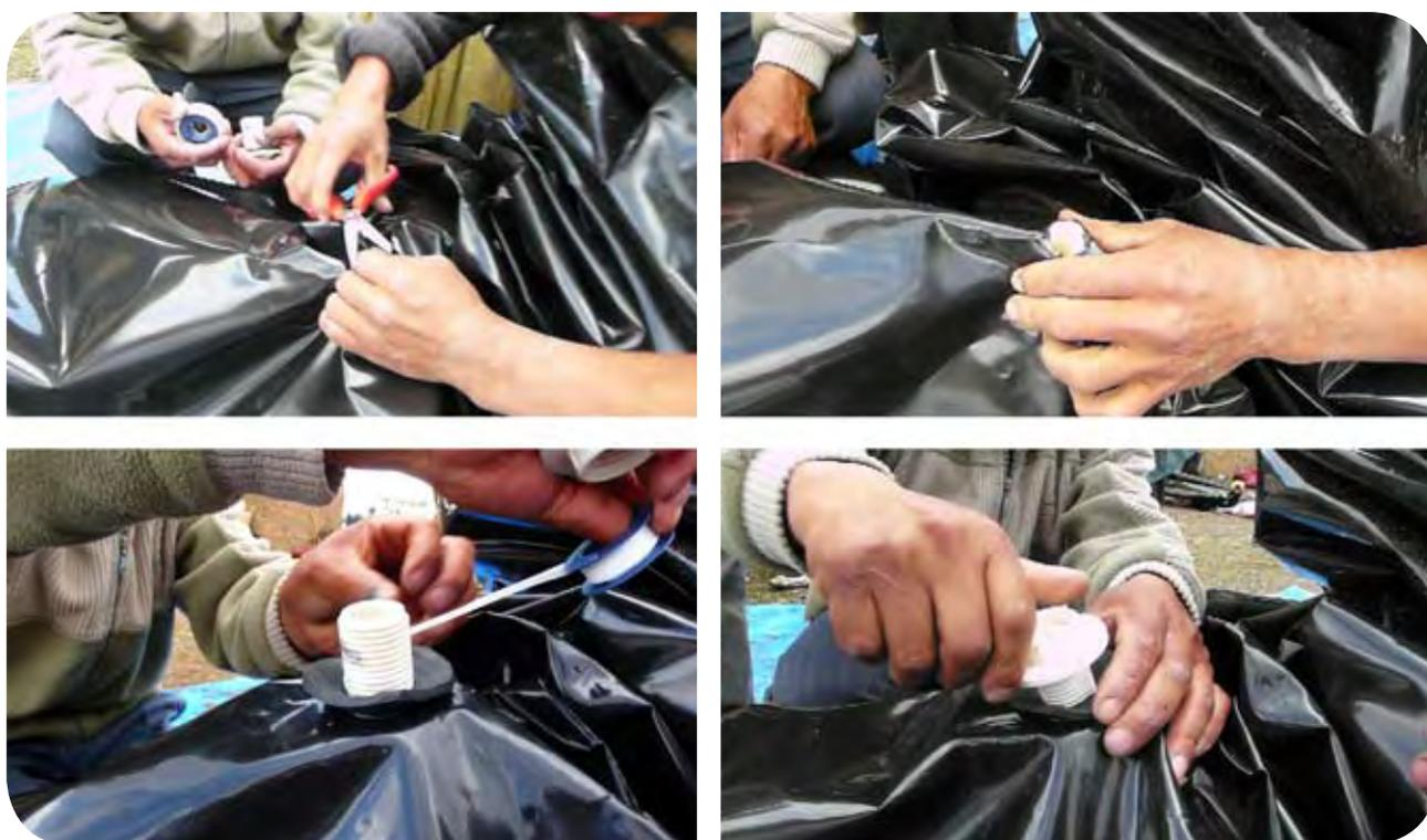
**Figura 16:** para la colocación del pasamuros (o flange) hay que hacer un corte en la parte central de la manga de doble capa. Con unos discos de goma, y apretando posteriormente, la flange será una salida sellada al biodigestor que permitirá llevar el biogás hasta la cocina.
