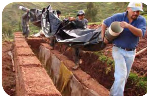
**Figura 20:** Una vez construido el biodigestor hay que meterlo en la zanja, con mucho cuidado de que no rocen los pliegues del plástico con ninguna pared ni piedra, ya que se podría dañar el plástico. Esta es una parte crítica en la que hay que extremar los cuidados.
