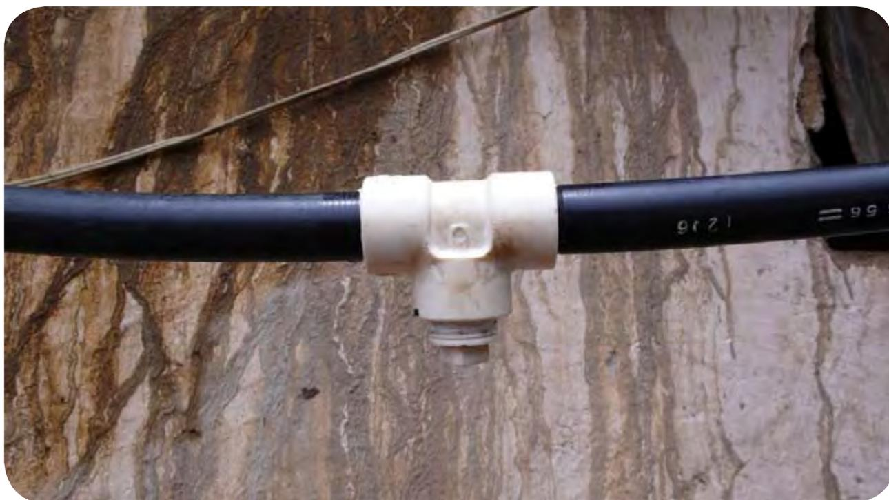
**Figura 27:** En los puntos bajos de la conducción de biogás se puede poner una tee con la tercera salida cerrada con una rosca. De esta manera si se acumula agua en este punto bajo, se puede purgar abriendo la rosca de la tee.
