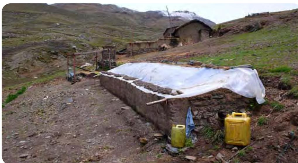
**Figura 1:** Biodigestor familiar de bajo costo instalado en Pakuani (La Paz, Bolivia) a 4.221 metros sobre el nivel del mar. Este biodigestor produce biogás suficiente para cocinar 4-5 horas al día, alimentándolo con 20 kg de estiércol fresco y 60 litros de agua diariamente. Produce además 80 litros de fertilizante al día. Como curiosidad, este es el biodigestor más alto del mundo funcionando.
