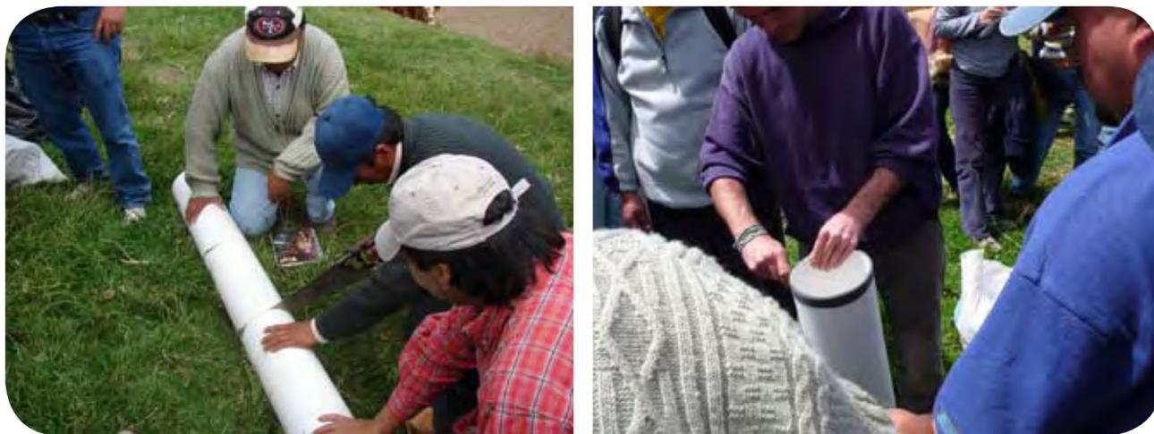
**Figura 17:** Las tuberías de entrada y salida son de PVC de 6” de diámetro. Normalmente se compra un tubo de 4 m, que hay que cortar en cuatro piezas de un metro cada una. Hay que proteger las bocas del tubo de entrada y el de salida que van a estar dentro del biodigestor. Amarrando liga neumática sobre el canto es suficiente.
