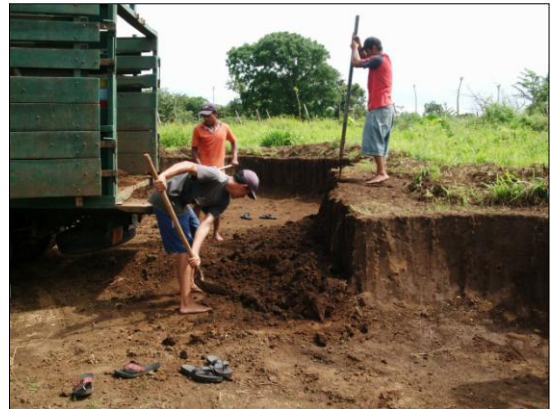
Fig. 12 Extracción de suelos en Apataco
