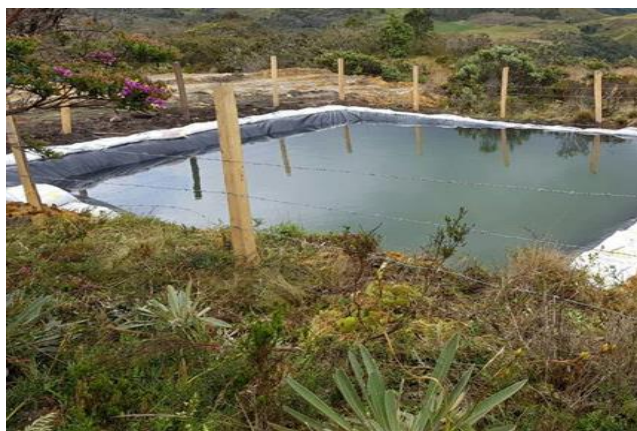
Figura 19. Cercado del perímetro del reservorio de agua
