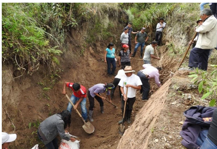
Figura 18. Excavación del reservorio de agua
