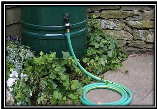
Figura 6. Almacenamientos del agua captada
