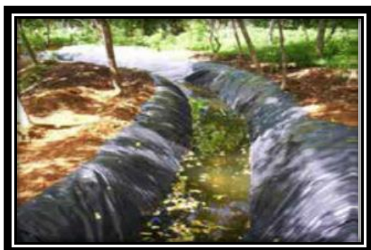
Figura 9. Colecta de agua en zanjas o canales excavados impermeabilizados con plástico
