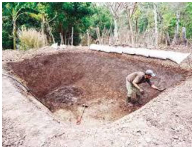
Figura 21. Mantenimiento del reservorio de agua
