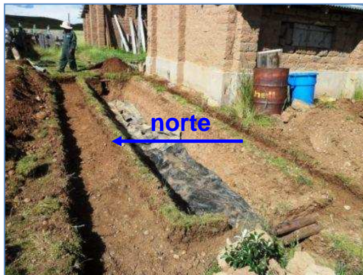
Canal excavado, para colocar la cimentación de las paredes
