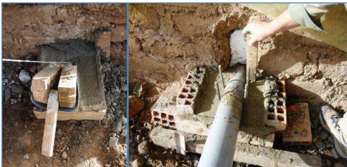
Tubería entrada de mezcla fijada
