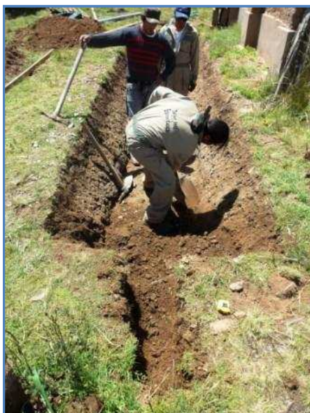
Excavación de la zanja
