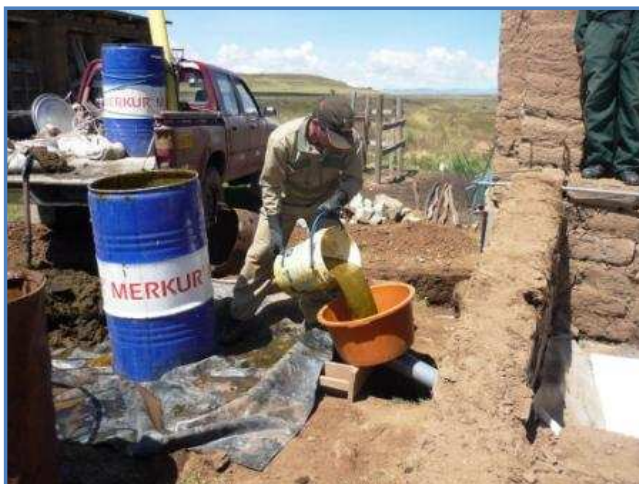
Llenado del digestor con mezcla.
