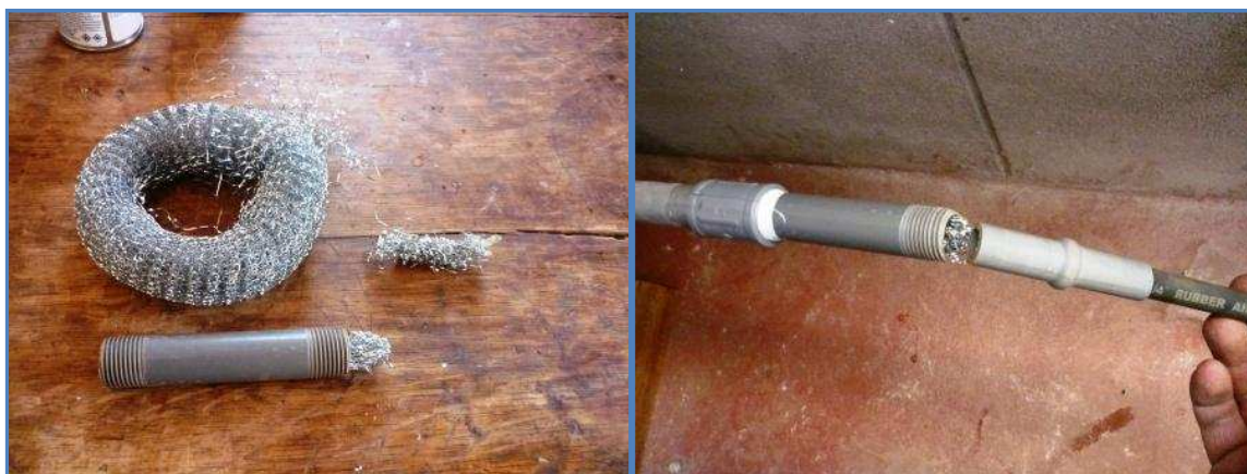
Esponja de hierro colocada en la tubería
