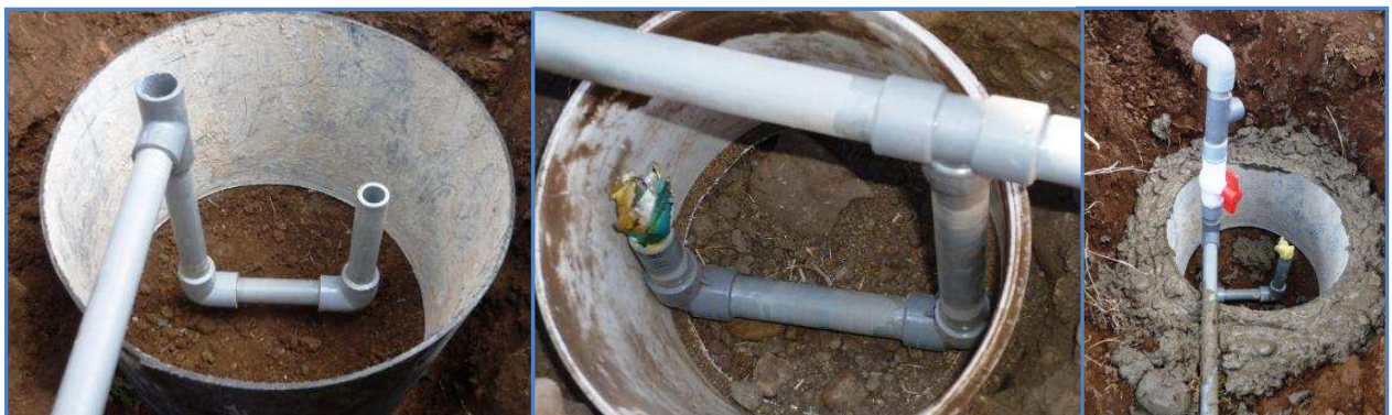
Instalación de la trampa de agua
