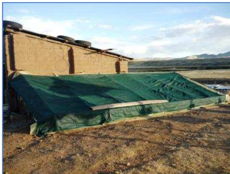
Techo del fitotoldo cubierto con malla rachel
