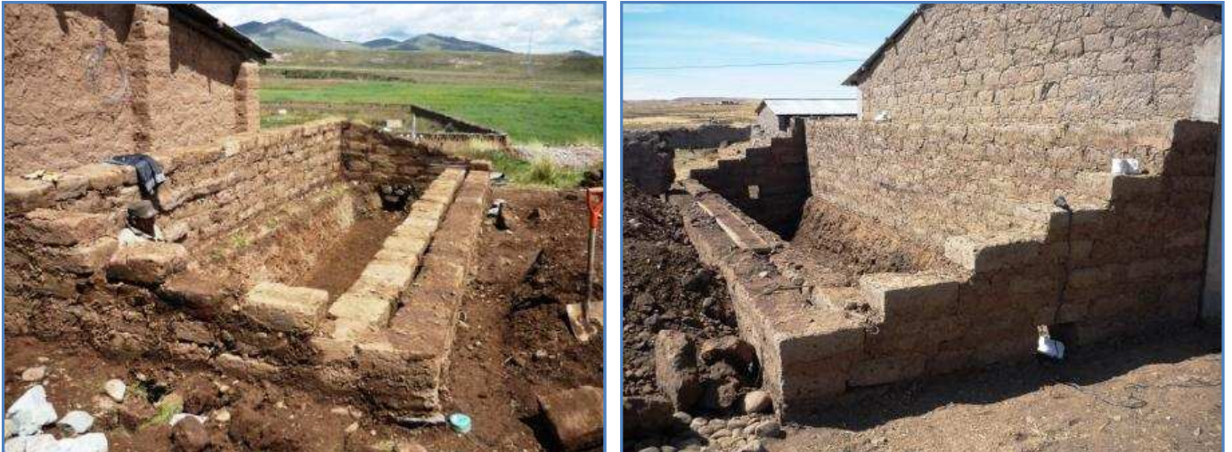
Paredes del digestor terminadas de ser levantadas
