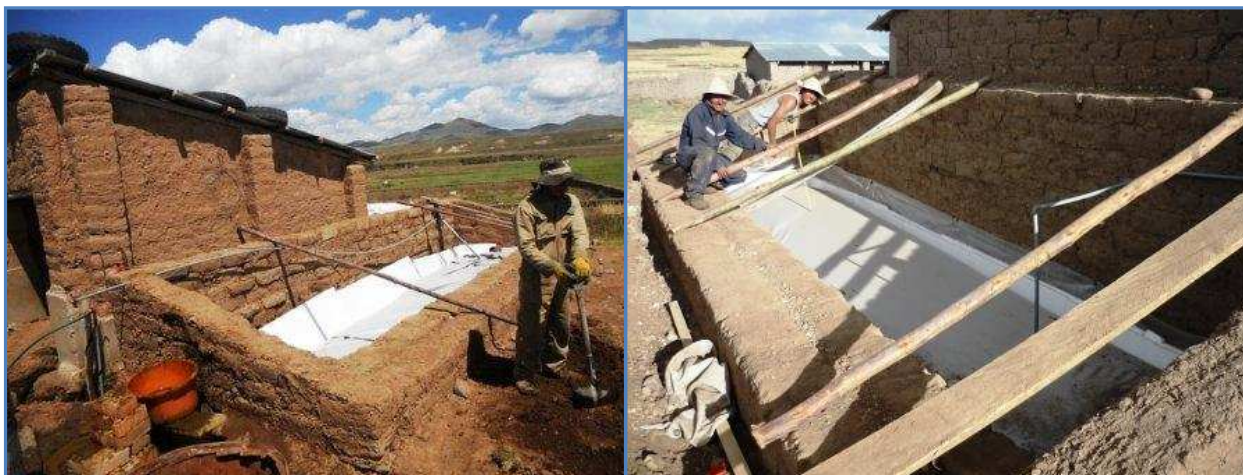
Posición final del digestor luego de terminar la carga inicial
