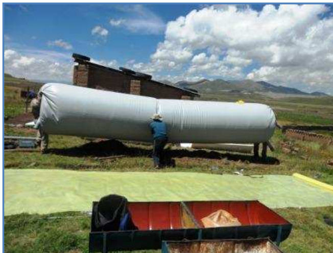
Traslado del digestor a la zanja
