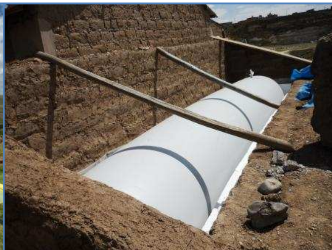
Digestor colocado en la zanja
