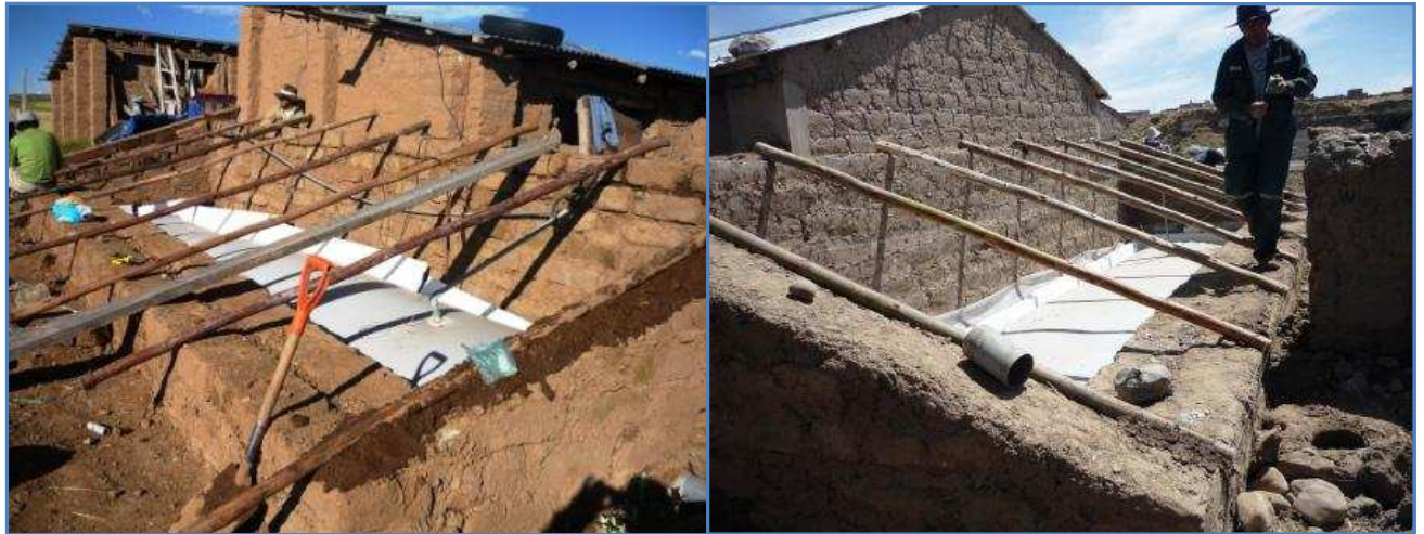
Rollizos colocados en las paredes laterales de adobe
