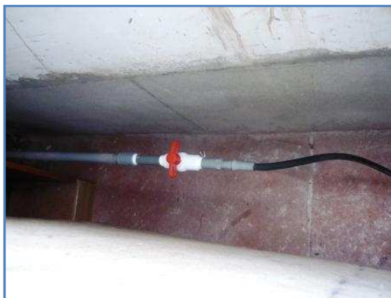
Llave de paso y manguera de caucho instalada
