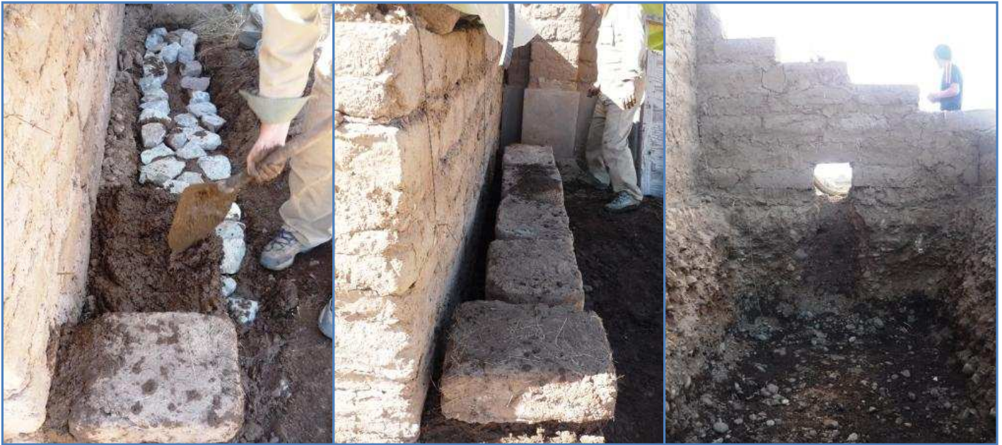
Colocando cimentación de las paredes Paredes del digester siendo levantadas Canal para las tuberías
