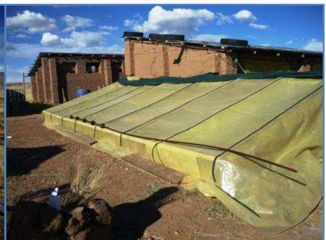
Alcance que tiene la varilla de agitación al interior del digestor
