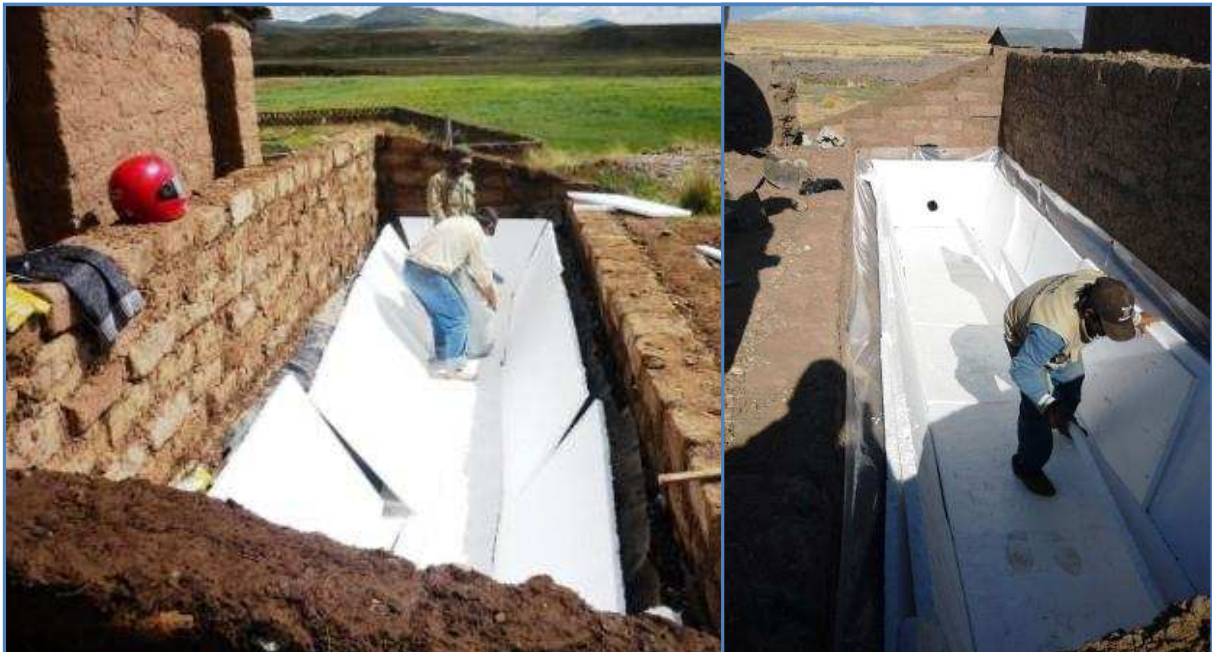
Zanja con el aislamiento colocado
