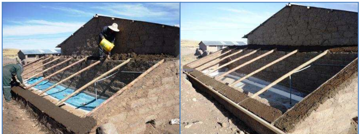
Colocando barro en la parte superior de las paredes
