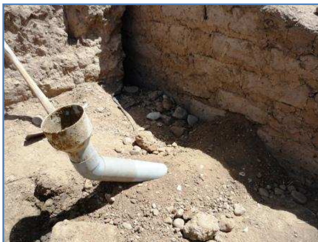
Tubería entrada de mezcla fijada
