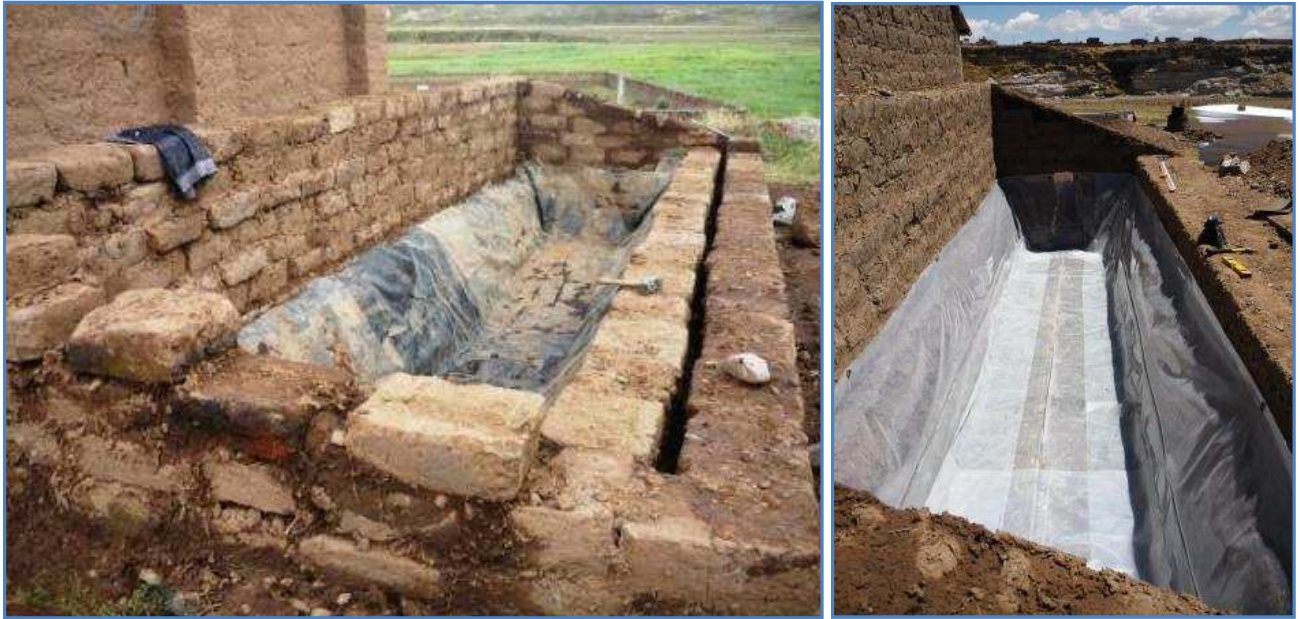
Zanja con la geomembrana / agrofil colocado
