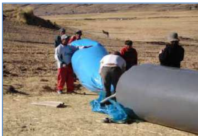
Inyectando aire al digestor con la manga fuente: Davide Poggio
