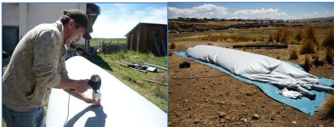
Inyectando aire al digestor
