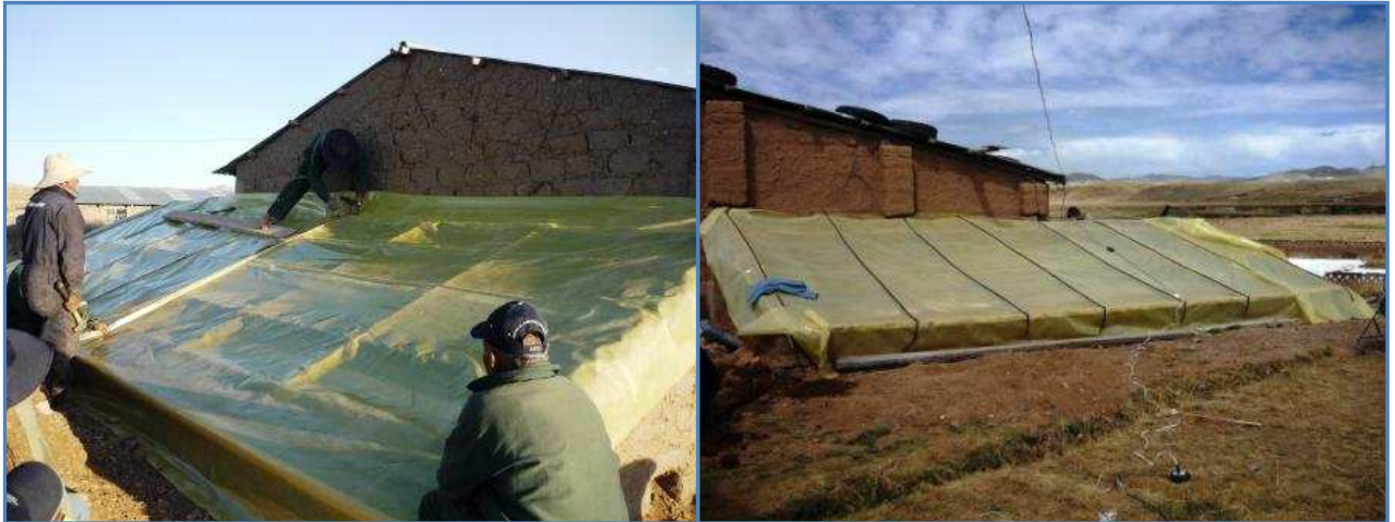
Colocando el techo del fitotoldo
