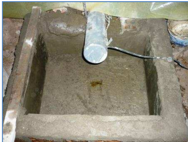
Paredes de la poza terminadas
