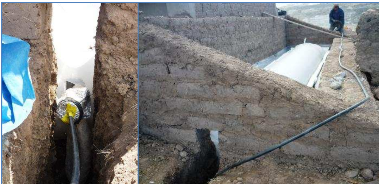
Llenando de agua al digestor
