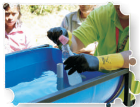
Fig. 18. Dilución de hipoclorito de calcio en botella con agua.
