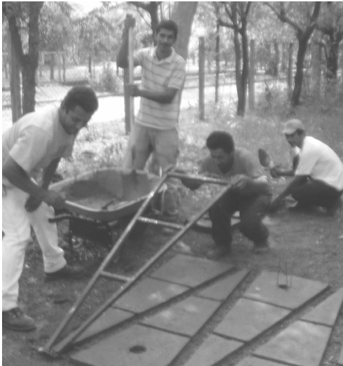
Tejas del techo de la cisterna
