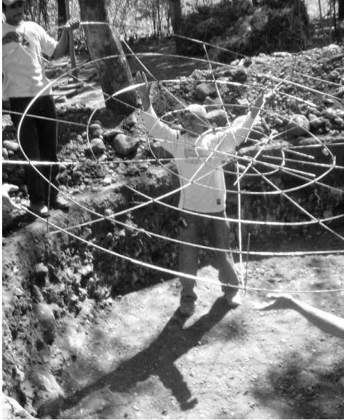
Telaraña de hierro que funciona como base de la cisterna
