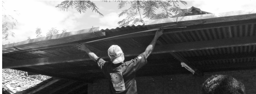
Instalación de las canaletas de zinc en el techo de una casa.
