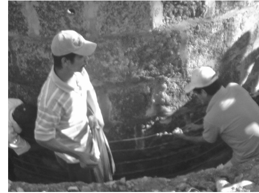
Primera etapa de colocación de hilos de alambre galvanizado
