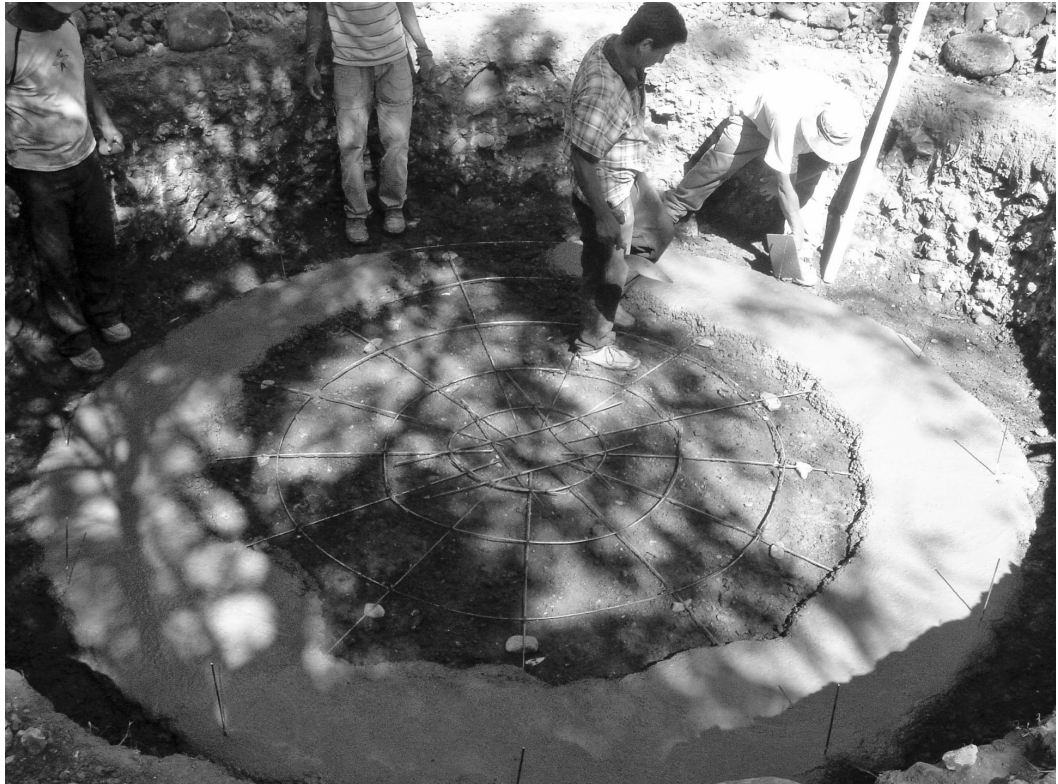
Construcción de capa de concreto de la base de la cisterna
