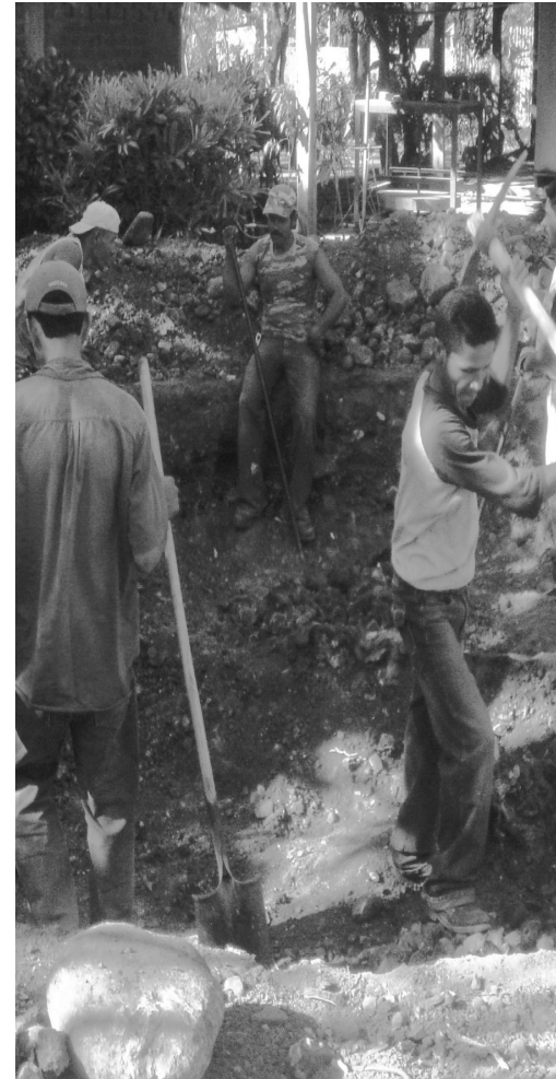
Proceso de demarcación y excavación del hoyo.
