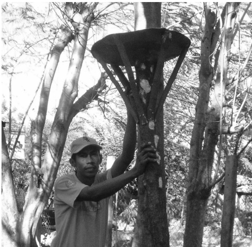
Construcción del techo de la cisterna
