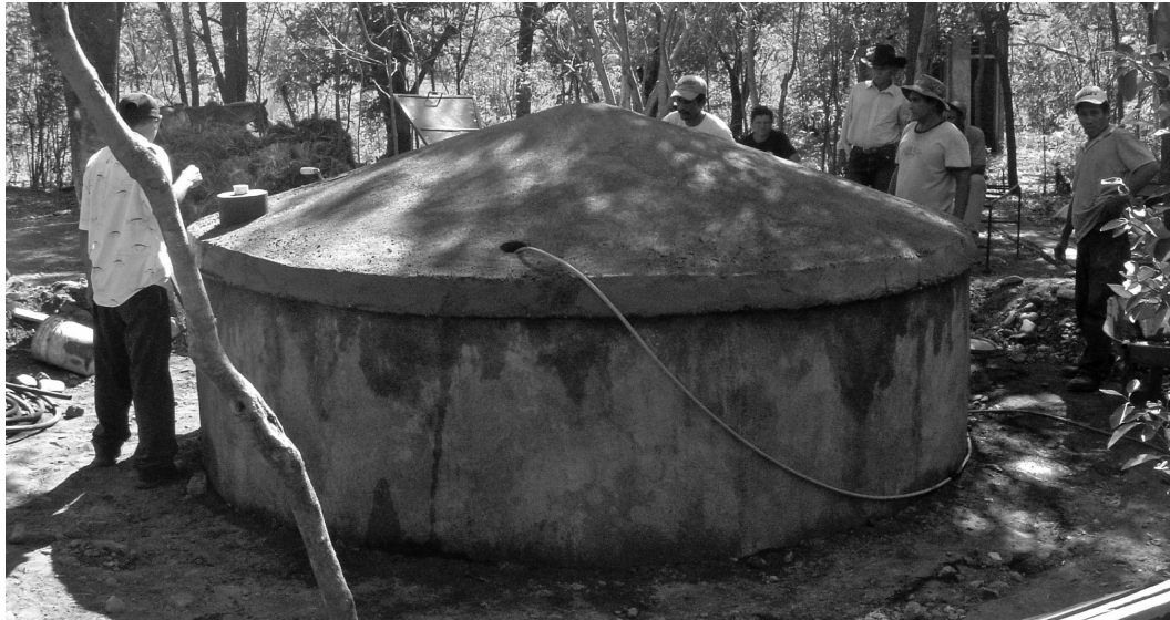
Cisterna lista para ser conectada a las canaletas.
