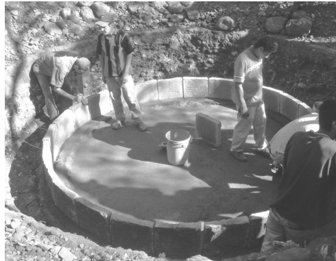
Colocación de la primera hilada de placas
