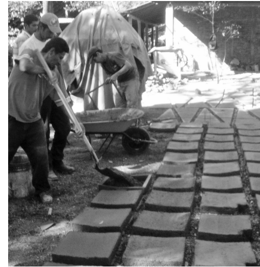
Elaboración de las placas de la cisterna.
