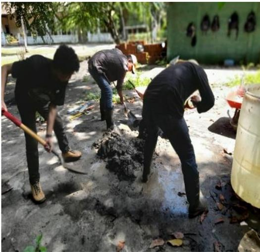
Realizaron colado de arena para elaborar la mezcla de mortero para el pegado de los ladrillos. La proporción utilizada fue 1:6 por cada bolsa de cemento se le agrego 6 baldes de arena.
