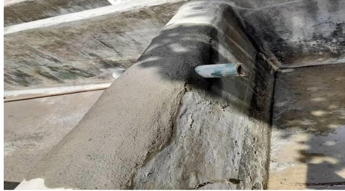
**Figura 26. Restauración de muros y repello grueso**
