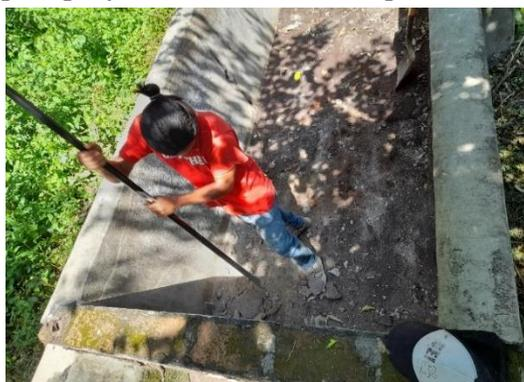
**Figura 24. Demolición del cascote viejo**
