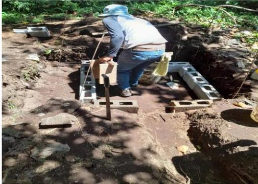
Durante la excavación también se determinó la dirección del canal mediante el uso de lienzas, de tal forma que los depósitos construidos quedaron en línea recta.
