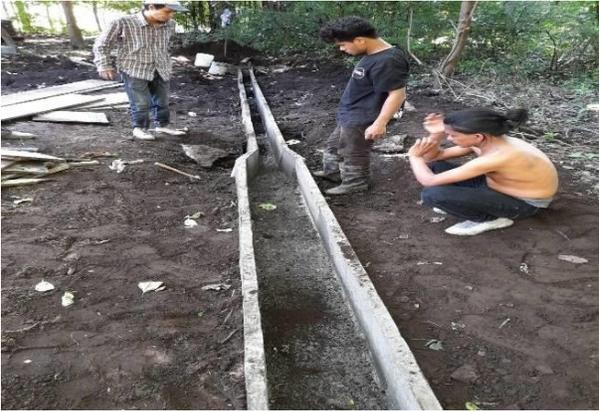
Después de tres días de la fundición se procedió a retirar las tablas del encofrado. Cabe destacar que se dejaron los tres días de secado para que el concreto alcance su resistencia a la cual fue diseñada de 3000 psi.
