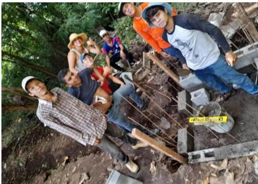
La construcción del depósito fue realizada con mampostería reforzada, es decir se utilizaron varillas corrugadas de acero de 3/8” para el fijado de los bloques. Varillas que al ser combinados con mezcla de mortero genera mayor resistencia a la construcción.
