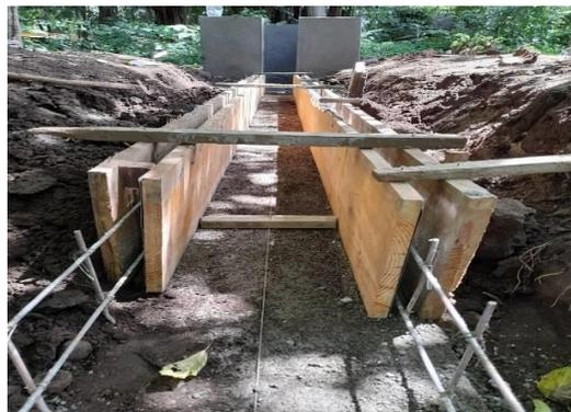
**Figura 38. Encofrado de las paredes.**
