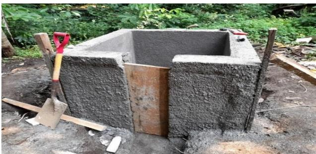
Se repellaron las paredes del depósito con la finalidad de darle impermeabilidad a la construcción, para generarle resistencia al momento que sea sometida a la presión de agua de  $1\text{m}^3$ .
