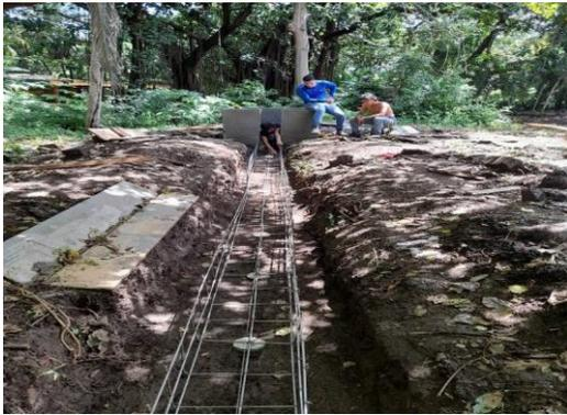
Se ubicó la estructura armada del canal sobre los quesos o separadores entre el acero y el suelo para que no haiga contacto entre ambos, la zanja estaba previamente nivelada y apisonada.
