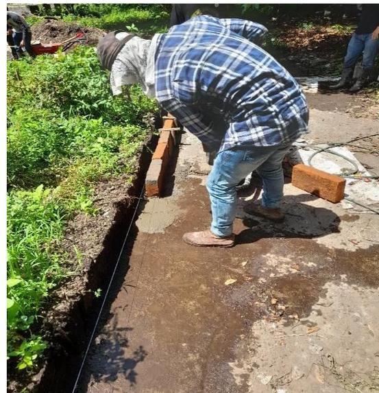
**Figura 22.a. Colocación de ladrillos**
