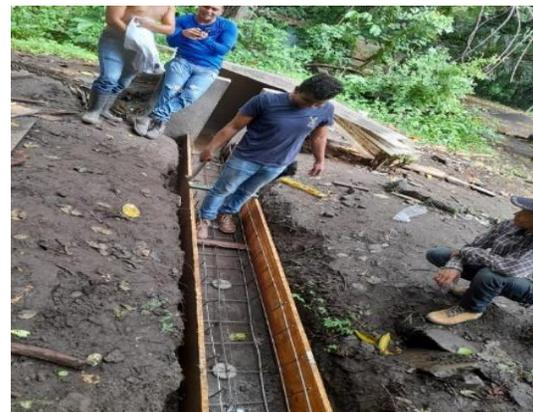
**Figura 36. Revisión del encofrado.**
