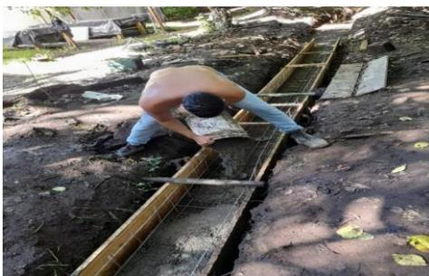
Una vez encofradas ambas secciones del canal se procedió a la fundición o el llenado de la base o cascote.
