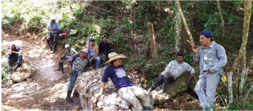
1 Elaboración de Gaviones por beneficiarios del organismo El Porvenir
