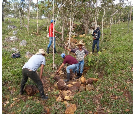
9 Elaboración de diques de piedra en puntos de riesgo en la comarca Tierra Amarilla
