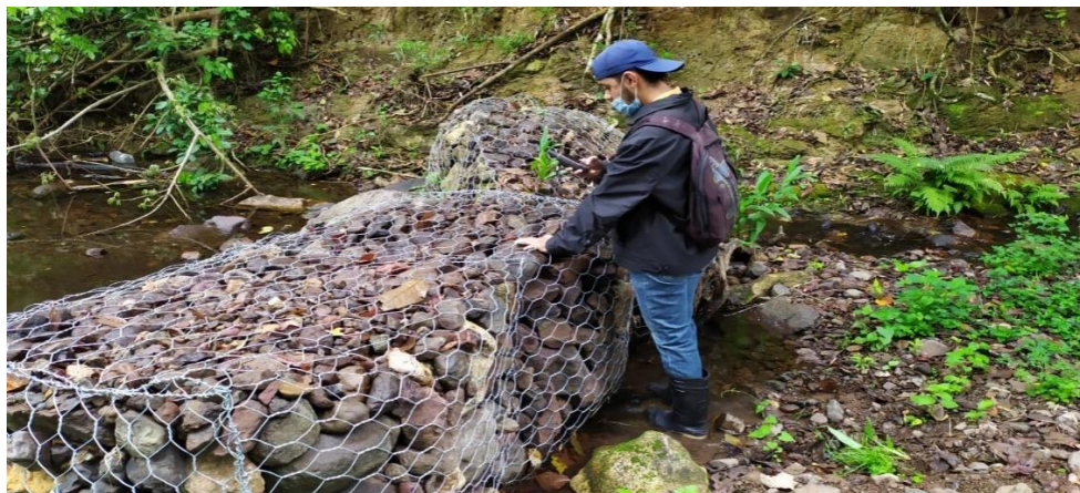
3 Valoración e inspección de Gaviones en la comarca Tierra Amarilla
