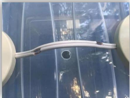
Figura 64. Retiro de goma para conexiones
