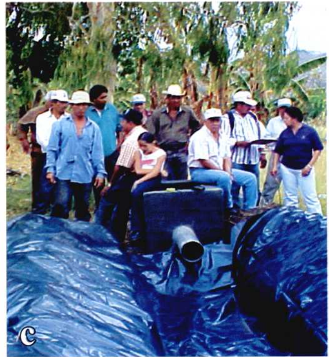
Figura 2. Instalación del biodigestor plástico. (a): fosa abierta; (b): salida del desagüe y fosa; (c): vista panorámica de la fosa con su entrada y salida
