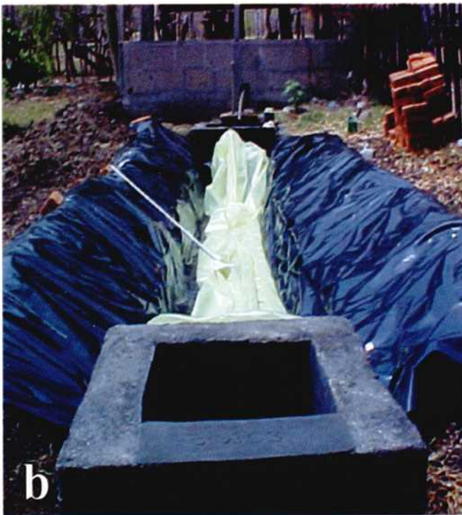
Figura 2. Instalación del biodigestor plástico. (a): fosa abierta; (b): salida del desagüe y fosa; (c): vista panorámica de la fosa con su entrada y salida
