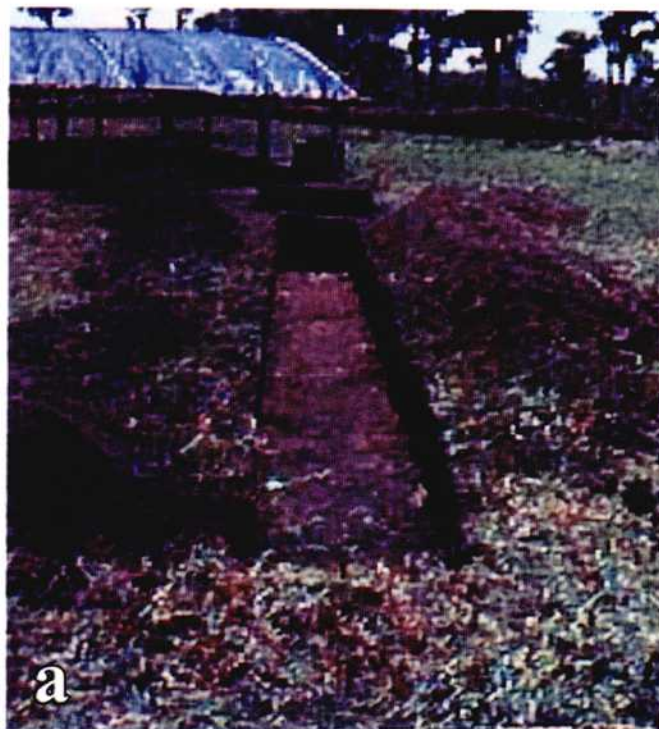
Figura 1: Dimensiones de la fosa para un biodigestor plástico. Fuente: CIPAV, 1995.
