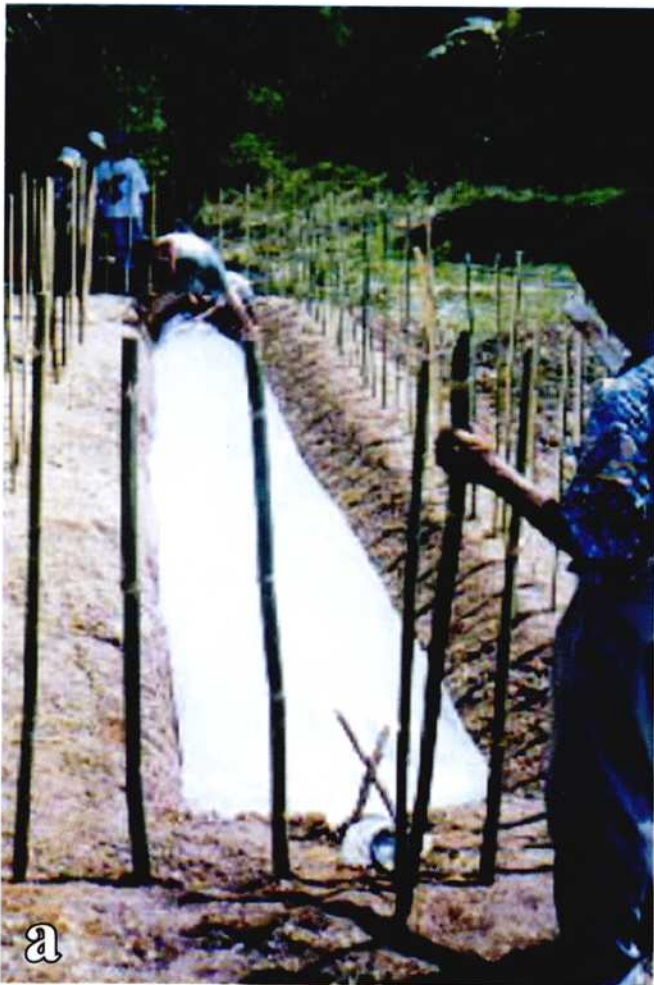
Figura 7. Protección del biodigestor: a) con bambú; b) y c) techado y paja.
