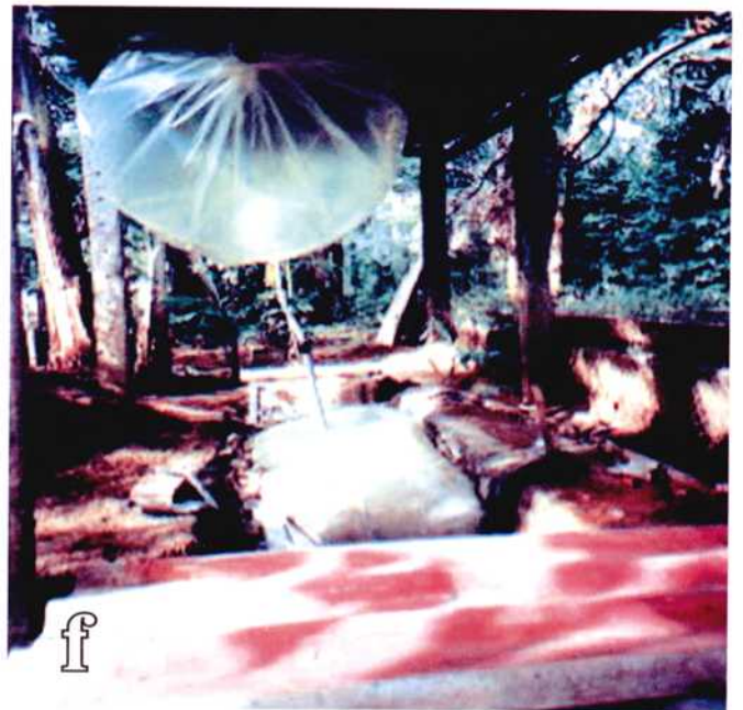
Figura 11. Proceso de instalación del biodigestor plástico: a) llenado con material; b) recién instalado; c) reservorio lleno de biogás; d) proceso de instalación; e) protección del biodigestor y f) en plena producción.
