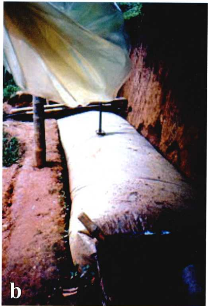
Figura 7. Protección del biodigestor: a) con bambú; b) y c) techado y paja.
