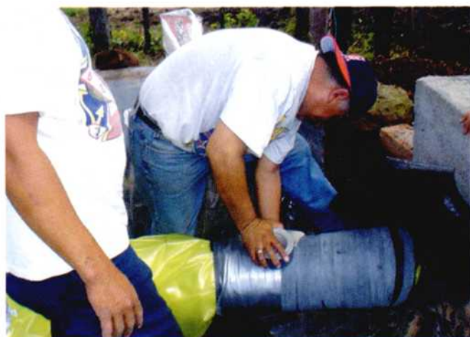
Figura 5. Fijación del biodigestor plástico a la caja de entrada y salida.
