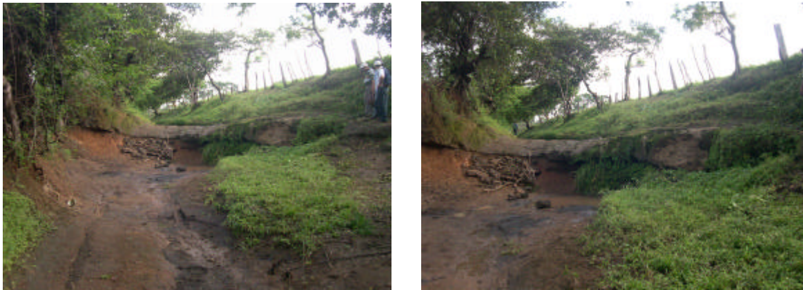
Figura 20. Tramo de camino en mal estado La Conquista -Las Enramadas.
