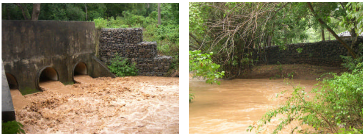
Figura 19. Obras de Mitigación en las cercanías de la comunidad La Mohosa.
