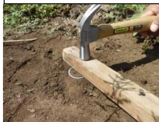
Figura 6. Proceso para penetrar el cilindro en el suelo
