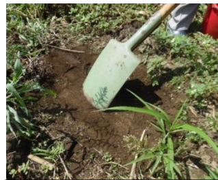
Figura 5. Limpia del terreno
