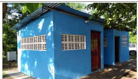
Figura 23. Punto crítico – Pozo de agua potable.
