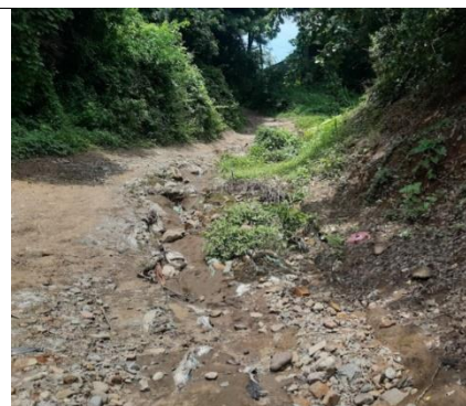
Figura 22. Punto crítico – Camino expuesto
