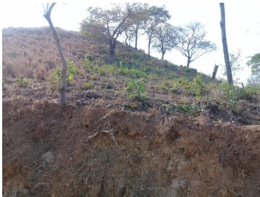
Figura 16. Usos del suelo con muy poca cobertura vegetal y evidencia de erosión
