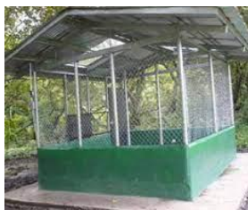
Figura 9: Bodega para residuos peligrosos (insumos)
