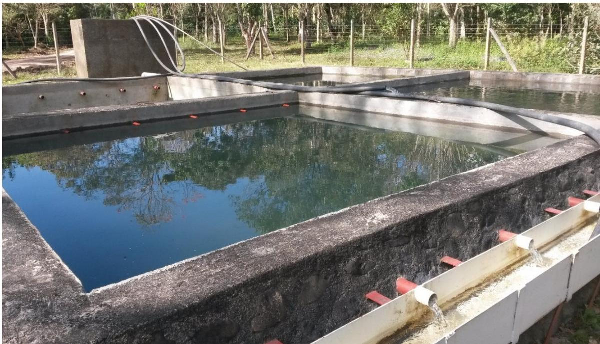
**Figura 8. Pilas de almacenamiento abiertas de fuente Santa Fe abastecedora del área urbana de La Dalia**
