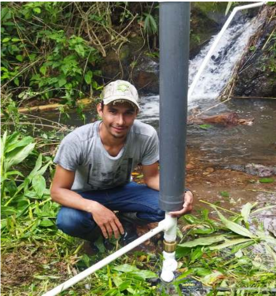
Anexo 10. Aforo en la fuente de alimentación e instalación de la bomba de ariete.
