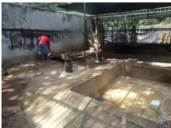
Anexo 11 y 12. Descensos de y pila semi enterrada
