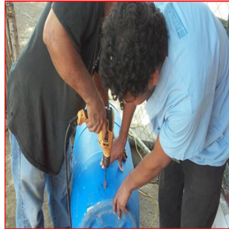
Anexo 6. Perforación de barril para abastecimiento de agua
