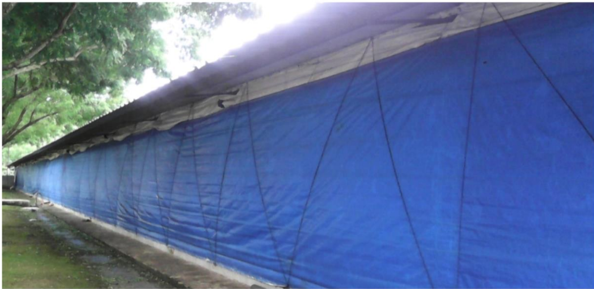
Foto 12. Buenas condiciones de aislamiento del galpón Tomada por Ubeda (2017)
