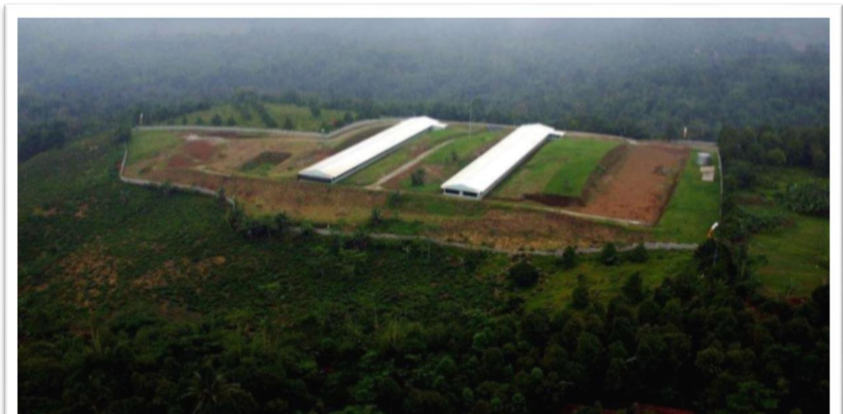
Figura 21. Aislamiento y distancia en granjas Fuente: Slideshare (2017)
