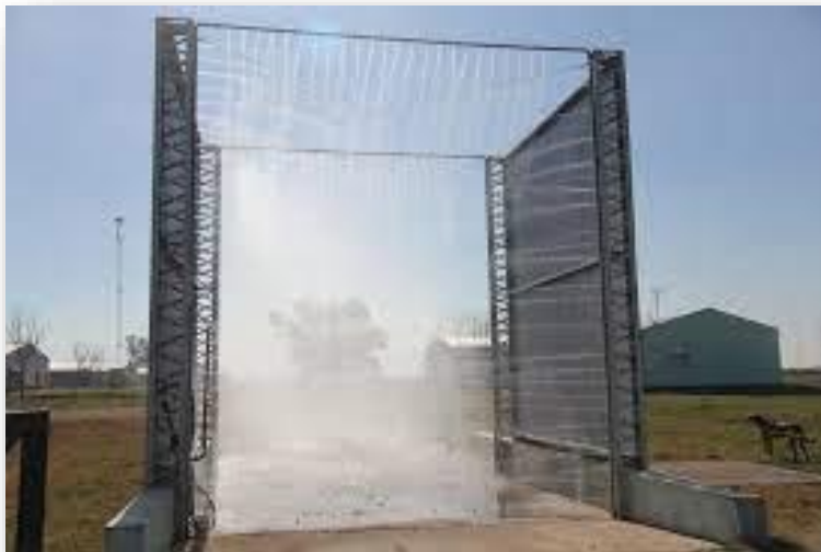
Figura 4. Arcos sanitarios para desinfección de vehículos al ingreso de la granja.
