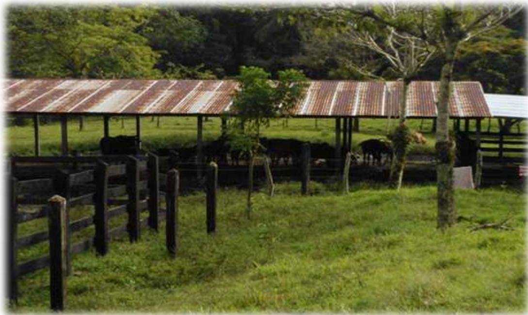
4. Instalaciones en buen estado (la Sandino)
