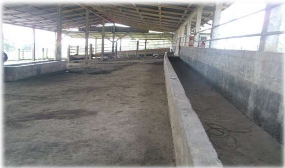
11. Instalaciones en perfectas condiciones (la Sandino)
