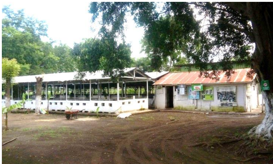
Figura 2. Instalaciones de la unidad de producción
