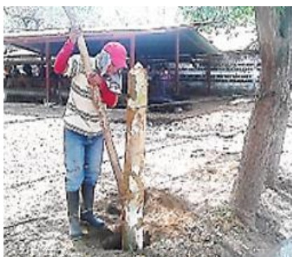
Fotografía 4. Reparación de cercas
