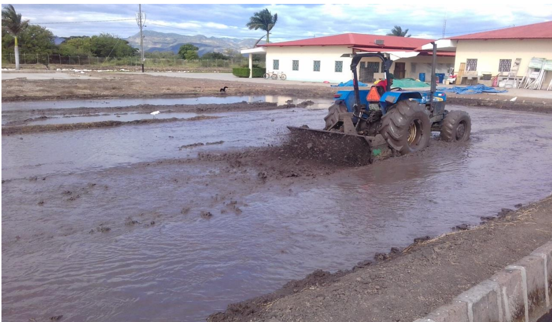
Preparación de terreno en aguas turbias.
