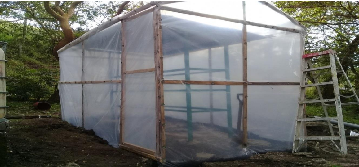
Anexo 3. Infraestructura protegida con plástico transparente calibre 1000
