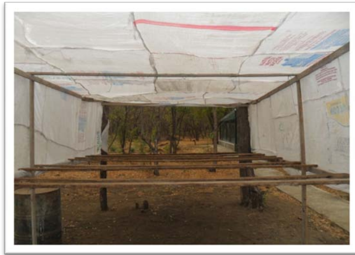
Construcción finalizada del invernadero no tradicional
