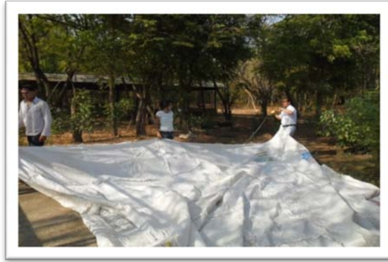
Techo hecha de sacos de nylon para cubrir el invernadero
