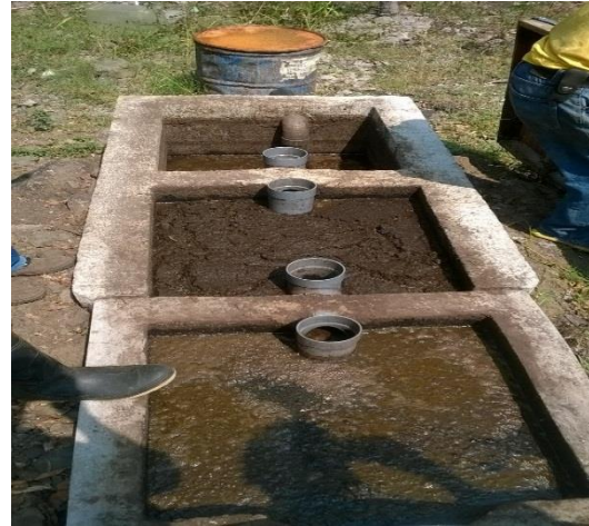
Anexo 3. Piletas almacenadoras de Biol en fincas ganaderas de Boaco
