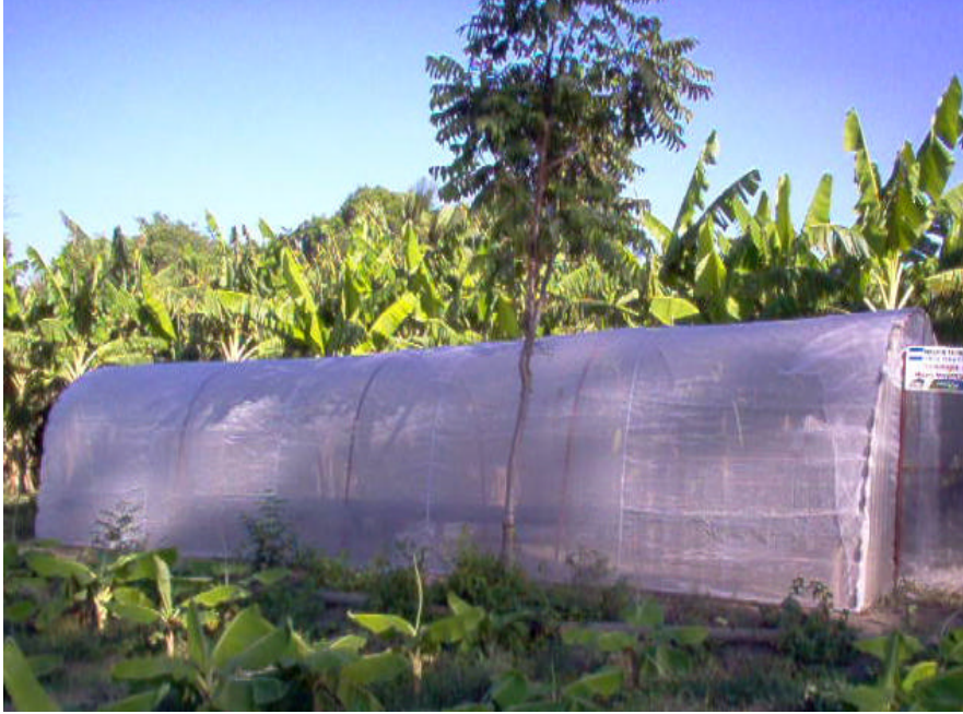
Anexo 1 Foto lateral de Microinvernadero. Modelo artesanal hecho con tubos de hierro galvanizado y cubierto con malla organdi de 50 Mesh.
