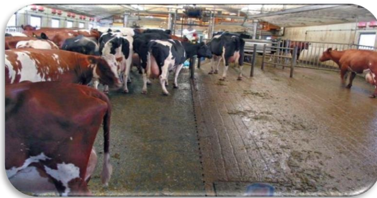
Figura 35. Corral de espera con suelo de goma sobre el hormigón Fuente (Callejos, S.f)
