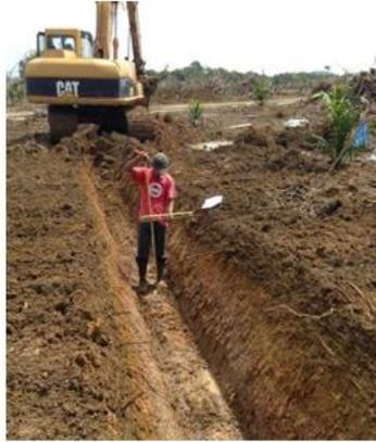
**Figura 5.** Verificado las dimensiones del canal
