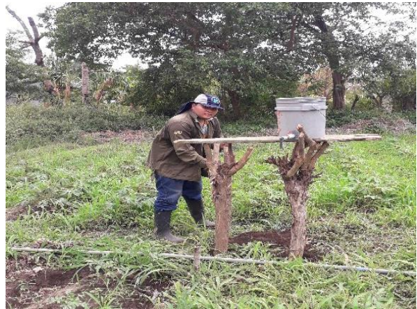
Figura 11. Instalación de sistema demostrativo de Riego por goteo
