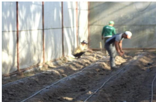
Figura 7. Instalación de cintas de riego
