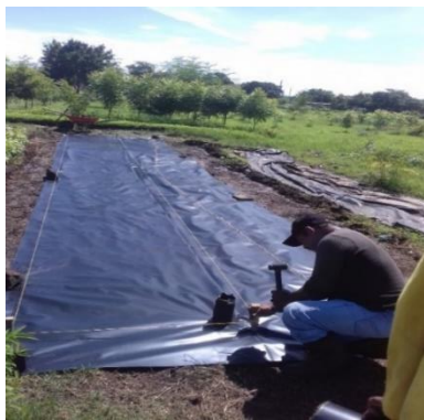
Figura 5. Construcción de bancales
