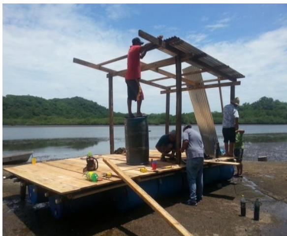
Figura. 3. Elaboración de caseta de monitoreo.
