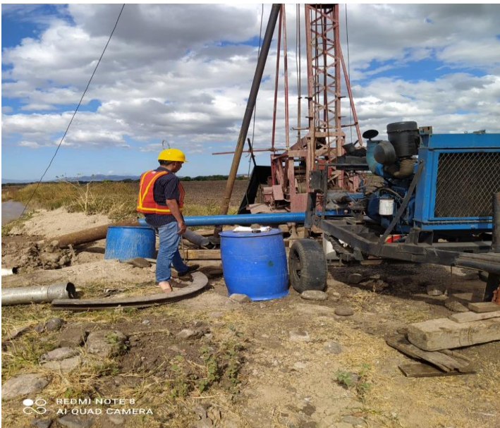
Anexo 9. Supervisión de la prueba de bombeo
