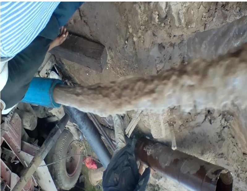
Figura 18. Inicio de la prueba de bombeo.
