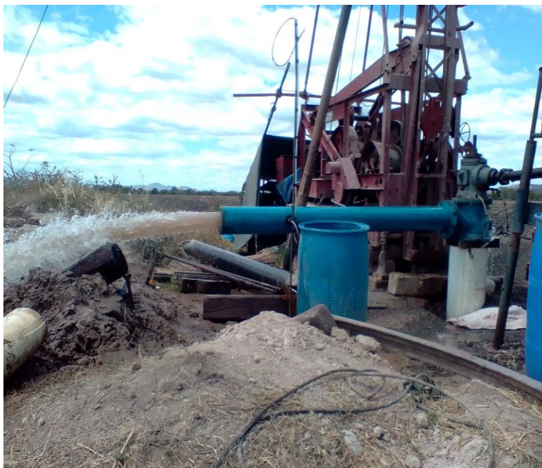
Figura 19. Prueba de bombeo en el segundo escalon.
