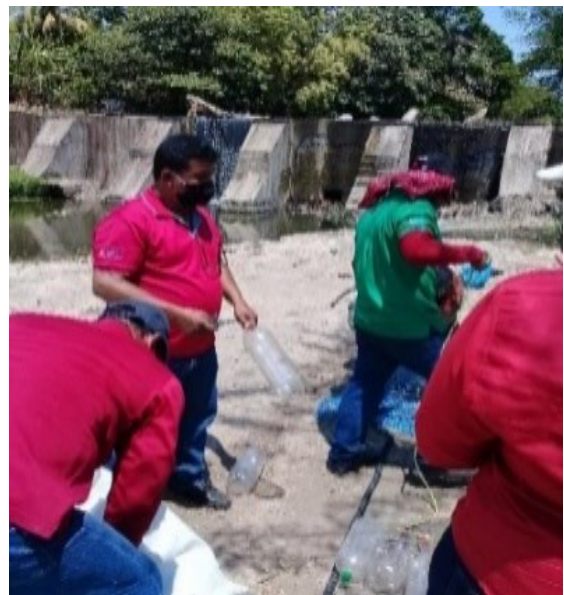
Figura 13. Construcción de una Nicabarda de 17 metros de longitud para la prevención de la contaminación en aguas superficiales, fue ubicada en el río Masachapa que desemboca a las a orillas del mar, la Nicabardas fue elaborado por el personal técnico del MARENA, 2020.
