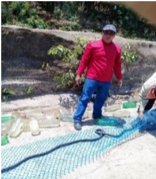
Figura 13. Construcción de una Nicabarda de 17 metros de longitud para la prevención de la contaminación en aguas superficiales, fue ubicada en el río Masachapa que desemboca a las a orillas del mar, la Nicabardas fue elaborado por el personal técnico del MARENA, 2020.
