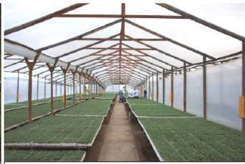
Madera aserrada y alambre el techo
