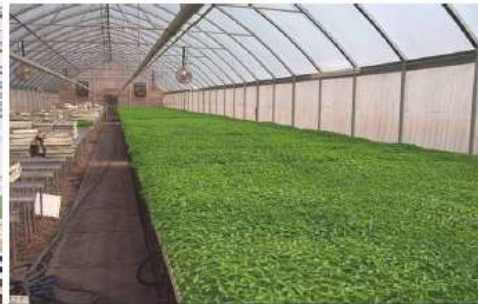
Estructura metálica toda
